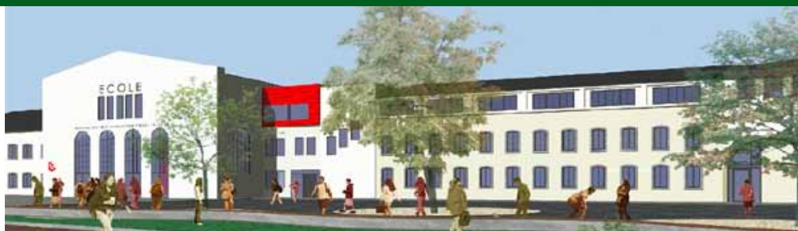
Die größte aktuelle ECOLE-Baustelle: Der Neubau des Internationalen Gymnasiums in der Barleber Bahnhofstraße.
